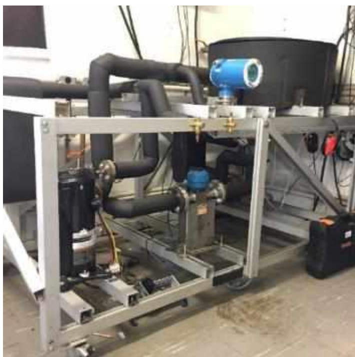
Figura 3.2 - Bancada experimental de refrigeração utilizada para a realização da avaliação experimental
